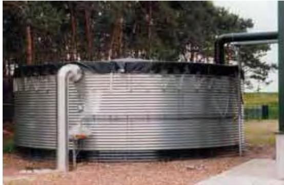
Réservoir en tôle ondulée protégée par un liner et couvert par différents moyens, y compris une couverture flottante pour éviter les odeurs.
