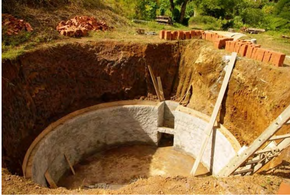
Etat d'avancement du digesteur le 16 juin 08
