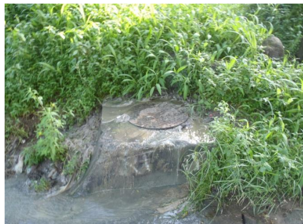
Figure 27 : Regard d'une canalisation d'eaux usées débordant lors d'un épisode pluvieux le 29 août 2011.
