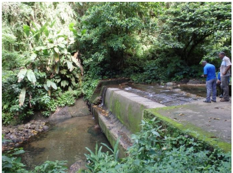
Figure 48 : La prise d'eau de Dumauzé
