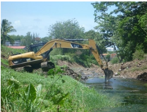
Figure 37 : Le curage de la Case Navire le 15 juillet 2014 (photo : Egis eau)
