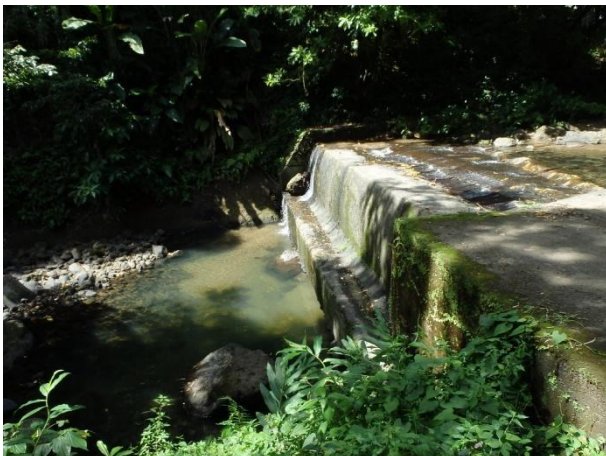
Figure 21 : La prise d'eau Dumauzé le 14 février 2014
