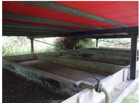
Figure 25 : Lits de séchage des boues de la STEU du CHP de Colson.
