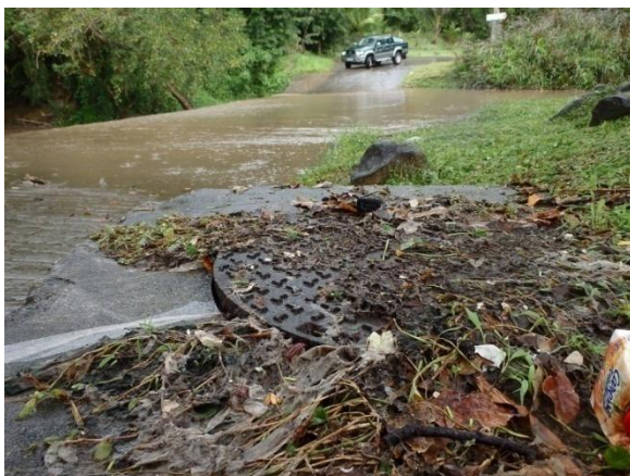
Figure 26 : Regard d'une canalisation d'eaux usées ayant débordé lors d'un épisode pluvieux le 6 février 2014.
