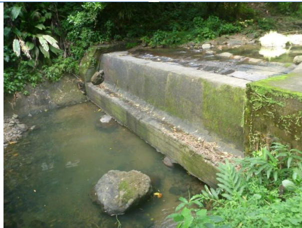
Figure 23 : La prise d'eau de Dumauzé le 13/12/2013
