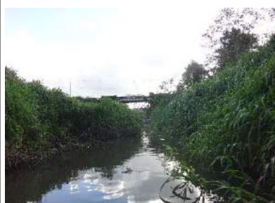
Vue vers l'amont de la station
