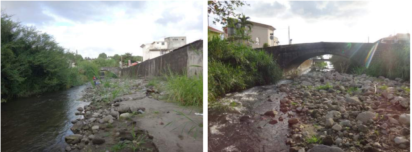
Figure 9 - Atterrissement en aval (photo de gauche) et en amont du pont (photo de droite) - Station n°08329101 - 2017 - SCE
