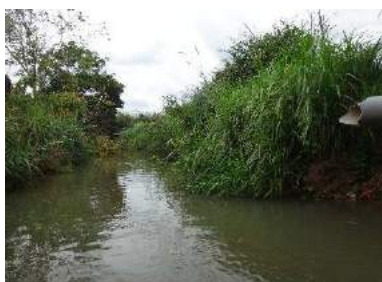
Vue vers l'amont de la station
