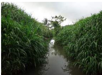
Vue vers l'amont de la station
