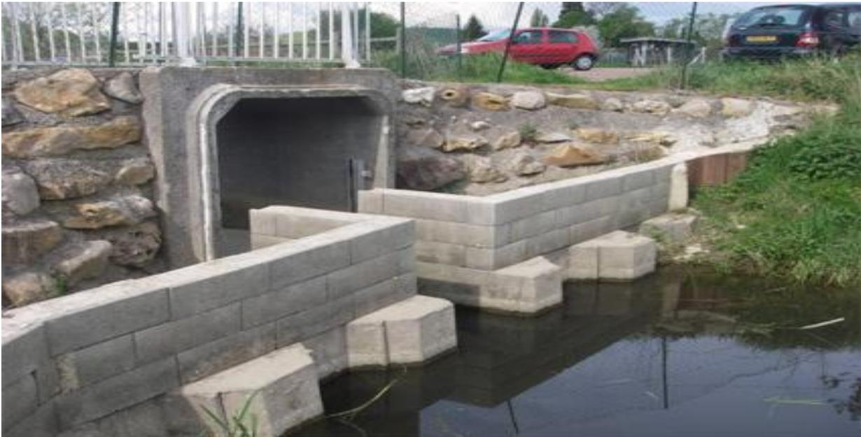
Figure 11 : Photographie du rehaussement d'un chemin avec l'ajout d'un ouvrage de régulation (IIB Sarthe Amont, 2007)
