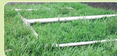
**Gestion de la biomasse** : Alternance de phases d'alimentation et de phases de repos : minéralisation de la biomasse accumulée
