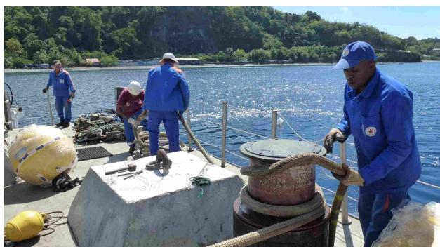
Figure 15 : Descente d'un corps mort à l'aide du cabestan
