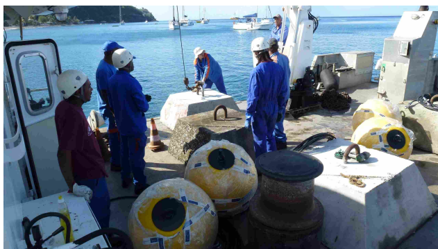
Figure 14 : Débordement d'un corps-mort avec la grue
