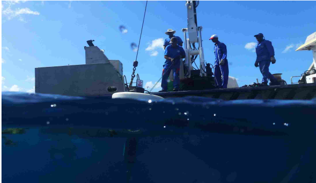
Figure 20 : Mouillage d'un coffre d'amarrage
