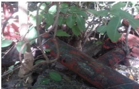
Réseau d'irrigation vétuste
