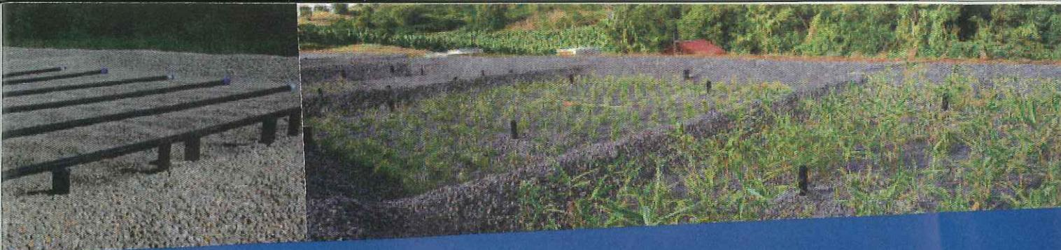
pour traiter des boues ou des effluents agricoles. La construction d'une station filtre plantes et végétaux implique la maîtrise de quelques points essentiels, comme la qualité des matériaux filtrants. En effet, la performance de ce système est basée sur la qualité des matériaux. La forme, la porosité, la texture des matériaux sont très importants et doivent être vérifiés. Des tests de percolation ont été réalisés de façon à vérifier toutes les amenées de matériaux sur le chantier.
