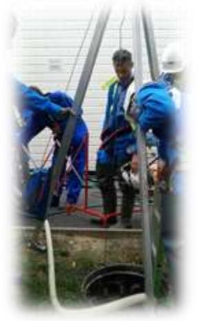
Préparatifs / Ventilation / Trépied / Stop-chute / Pompage / Nettoyeur HP / détecteur de gaz / bottes d'égoutier / masque de fuite / Barrières...
