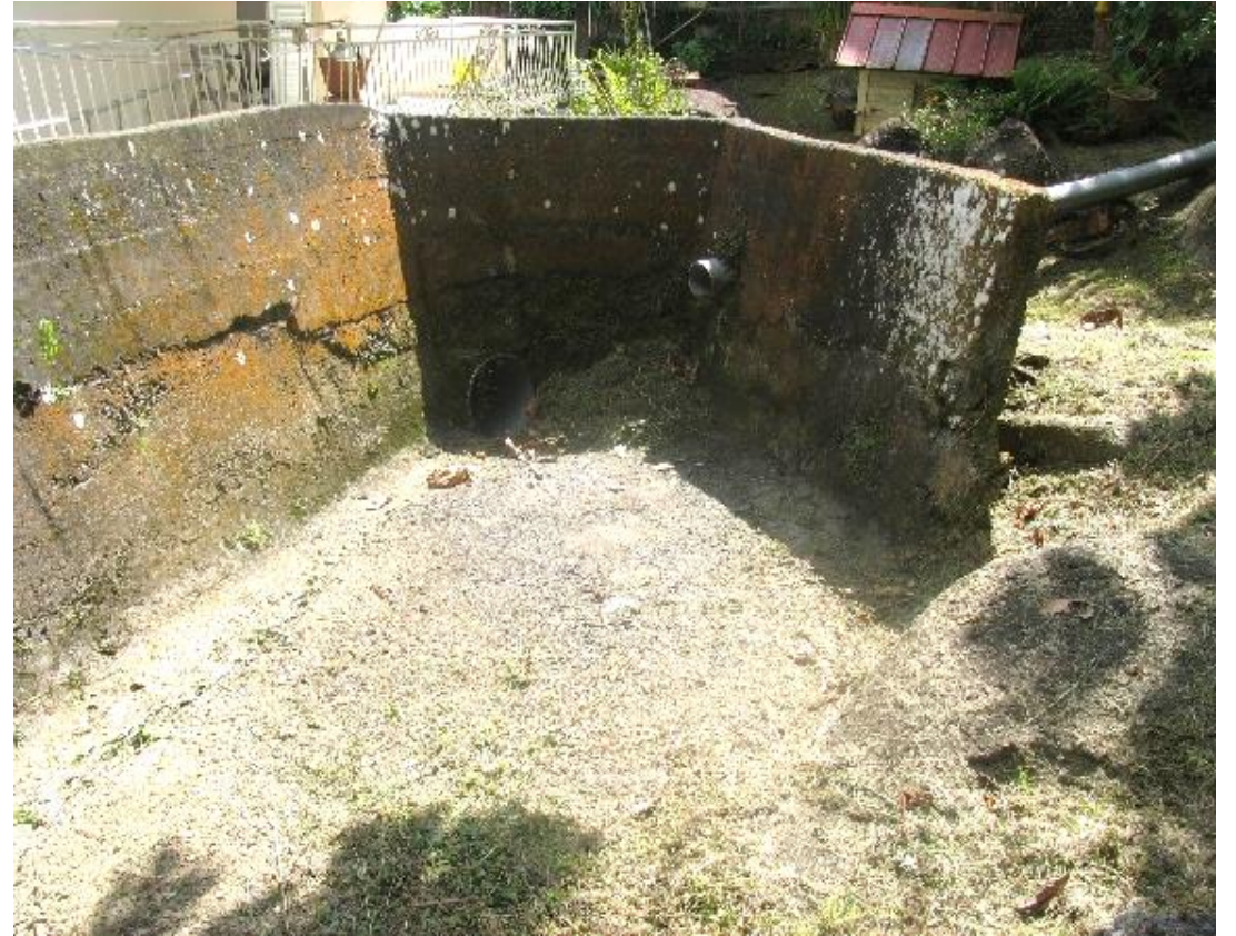
Jonction entre les deux tuyaux PVC
