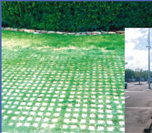
Exemples de revêtements de stationnement per Dalle gazon
