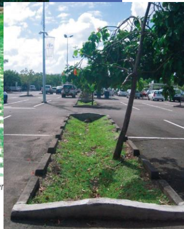
Noues filtrantes sur le parking d'un hypermarché à Génipa (Ducos)
